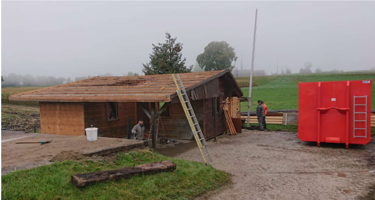
Abb. 1: Abbruch des bestehenden 'Hornusserhüttli' (Okt. 2020)
